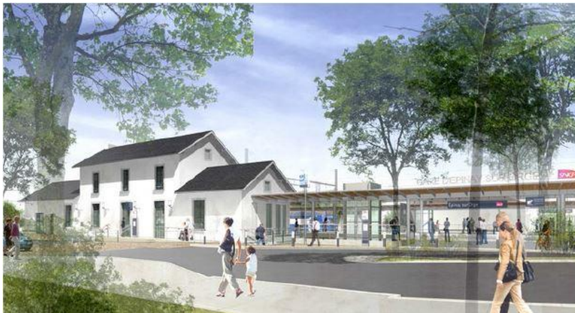
Vue de l'accès principal à la gare après les travaux (source : SNCF, 2016)
