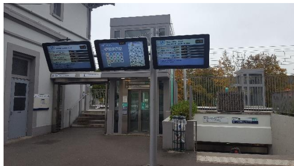
Information voyageurs et aménagements PMR en gare d'Orsay-Ville (source : SYSTRA, 2016)
