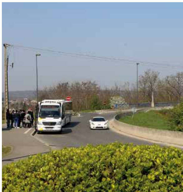
Mars 2022 : les travaux du ring du Pileu démarrent.
