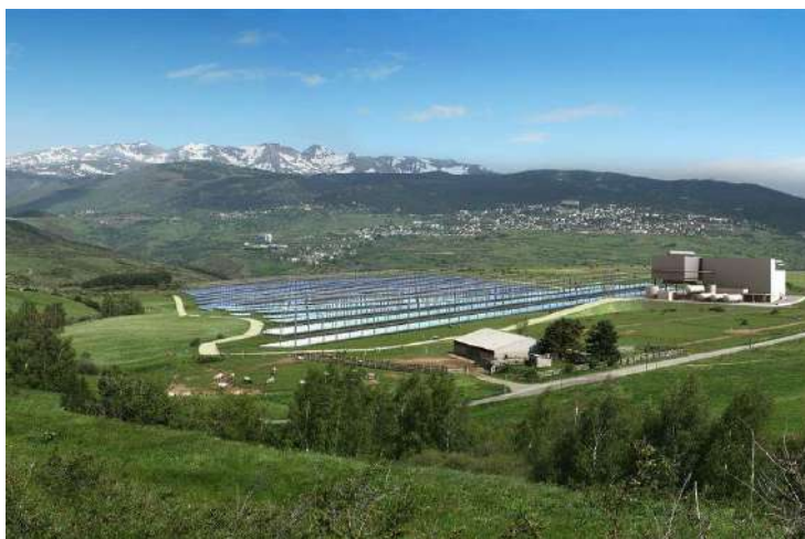
Centrale LLO dans les Pyrénées-Orientales (Source : Usine Nouvelle)
